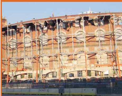
Barcelonas tjuvfångningsarena under pågående renovering.
